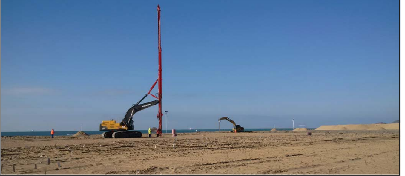
Türkmenbaşı Port, Zemin Islah İşleri, Türkmenistan
