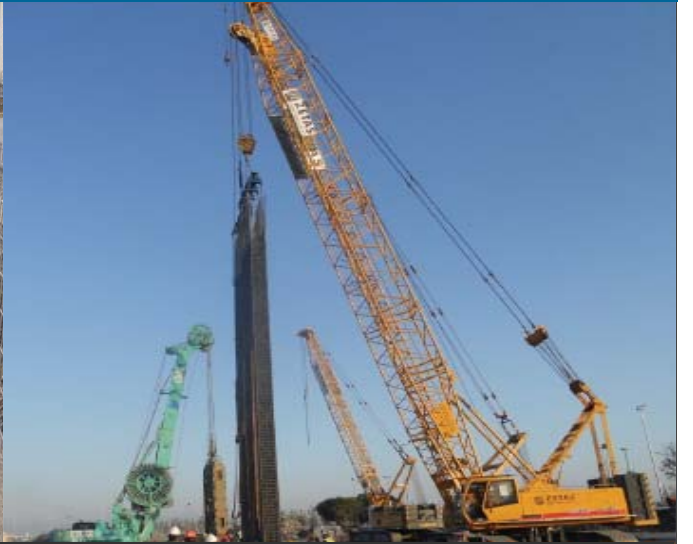
Avrasya Tünel, Yenikapı & Samatya Kavşakları Diyafram Duvar ve Fore Kazıkları, İstanbul
