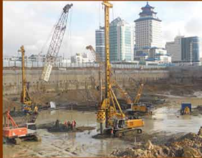
Abu Dhabi Plaza Astana İksa Sistemleri ve Fore Kazıklı Temeller, Astana - Kazakistan
