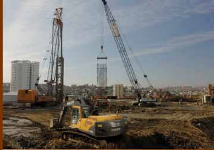
Ülker Arena Baret Temelleri, Ataşehir - İstanbul
