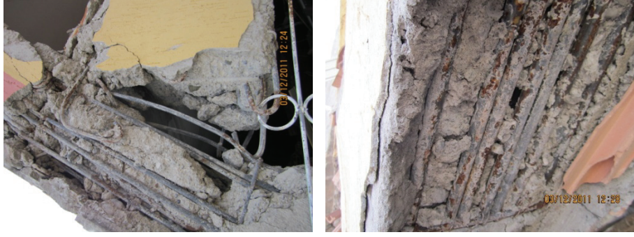
Şekil 3. Saha gözlemlerinden elde edilen kolon-kiriş birleşim bölgesi fotoğrafı
