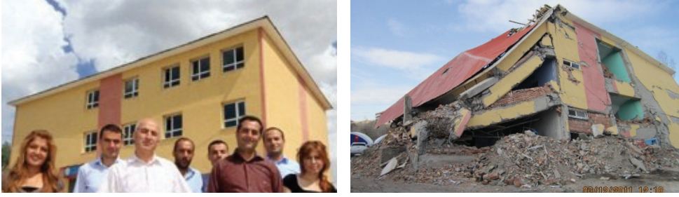
Şekil 1. Deprem öncesi ve Ekim 2011 Van depremi sonrası Gedikbulak okul binasından görüntüler
